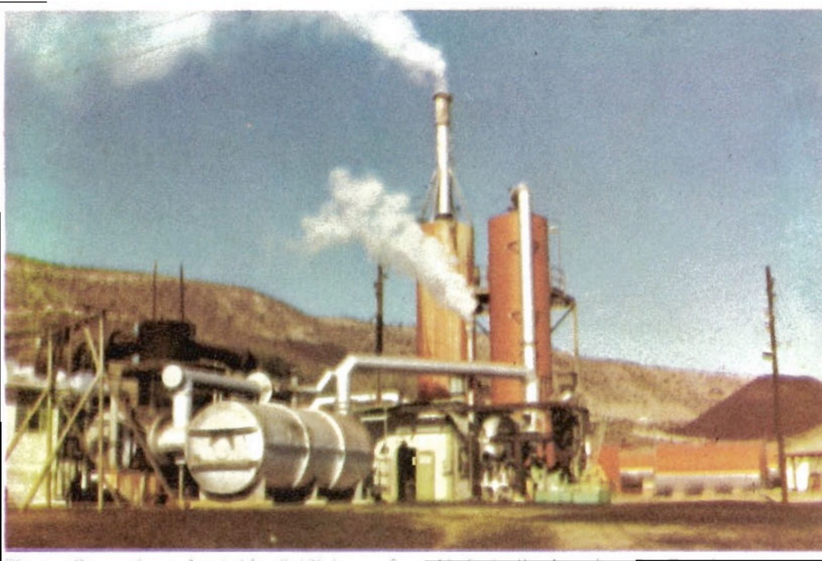
1970, Santa Rosalia, Territorio de Baja California, planta de ácido sulfúrico, cap. 70 tons diarias
